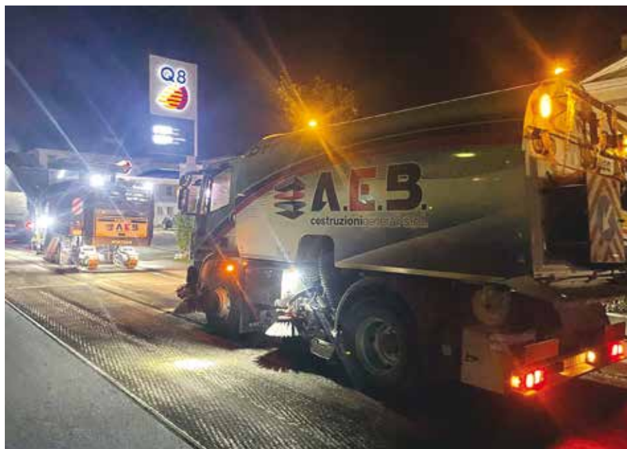
6. Un'accurata pulizia del fondo fresato a garanzia di massima adesione del manto d'usura
