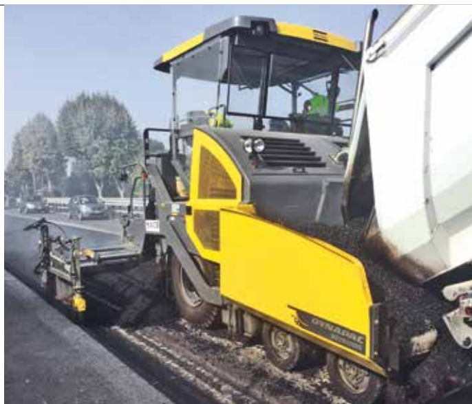
10. La fase di carico dell'asfalto ad alto modulo proveniente dall'impianto
