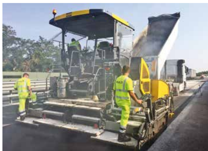
13. Sulla finitrice e sui rulli gli operatori si coordinano in continuo
