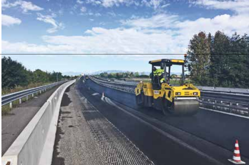
14. Il rullo tandem CC2300 ha i tamburi divisi per operazioni anche in spazi ristretti
