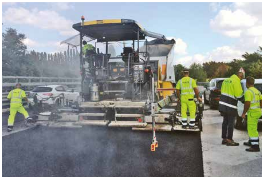
1. La nuova finitrice Dynapac SD2500WS in fase di stesa sulla Tangenziale di Treviso
