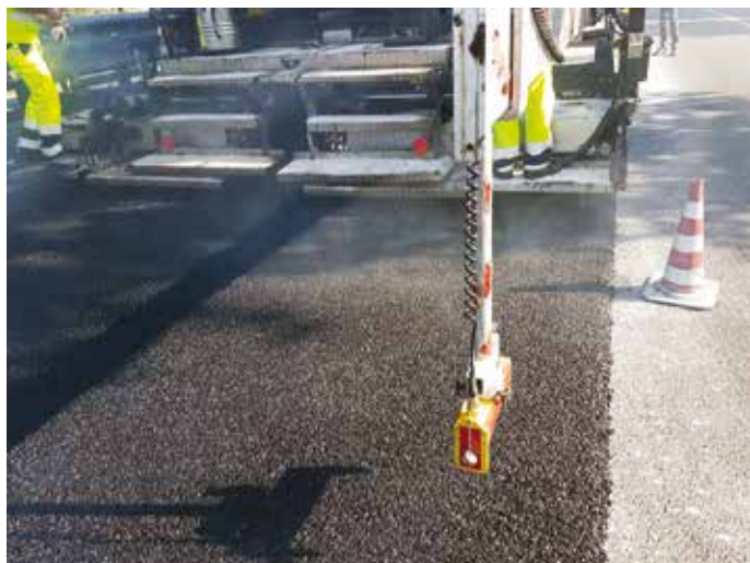
11 e 12. Il sistema di livellazione longitudinale integrato con tre punti di lettura su una barra di 13 m della vibrofinitrice Dynapac SD2500WS
