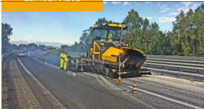
5. L'intervento di manutenzione straordinaria con stesa di manto d'asfalto ad alto modulo Split Mastix con spessore di 30 mm
