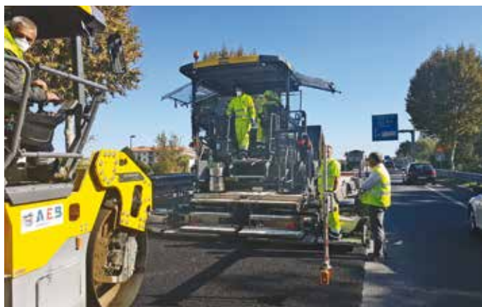
17. La compattazione al seguito della stesa
