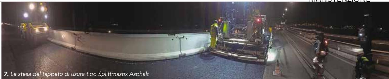
7. Le stesa del tappeto di usura tipo Splittmastix Asphalt
