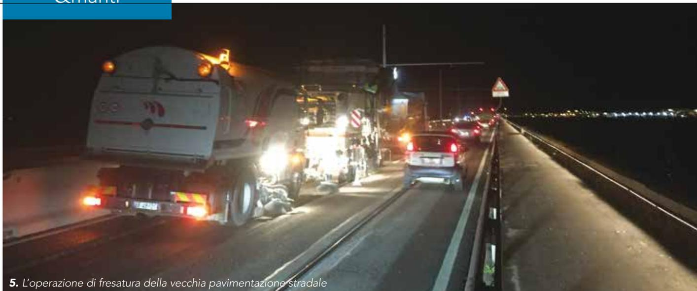
5. L'operazione di fresatura della vecchia pavimentazione stradale
