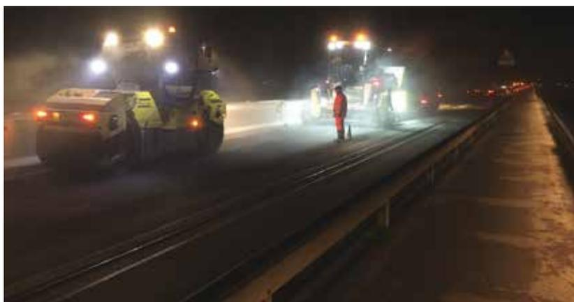
6. La stesa dello strato di collegamento binder a bitume ad alto modulo complesso
